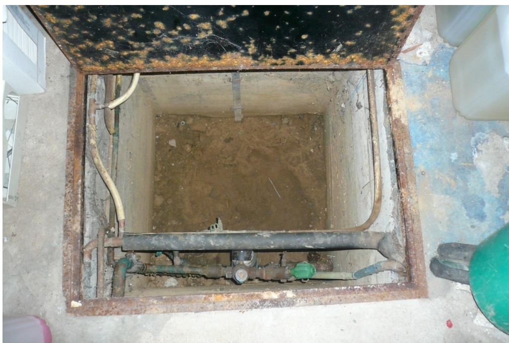
Abbildung 3 Wer prüft hier schon freiwillig den Rückflussverhinderer? Ein Einstieg ohne Leiter war noch möglich, rauskommen war eher eine Qual...
