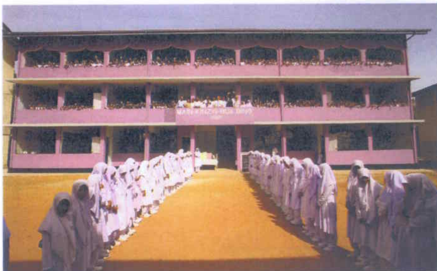
Das erst im Februar eröffnete Main-Kinzig-Building an der muslimischen Mädchenschule ist um ein drittes Stockwerk erweitert. Das gibt Platz für 720 Schüler.
