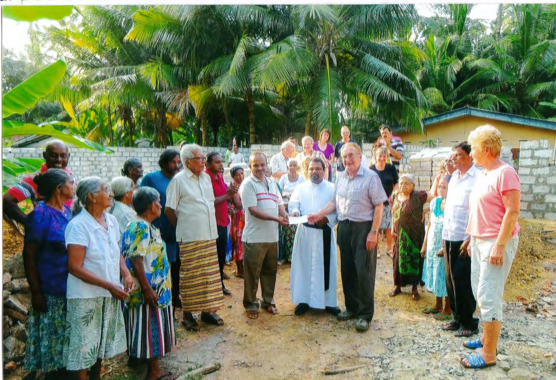
Die Bauarbeiten für eine neue Senioreneinrichtung für alleinstehende, pflegebedürftige alte Menschen haben bereits begonnen. Karl Eyerkaufert überreichte eine weitere Spende für das Bauprojekt.
